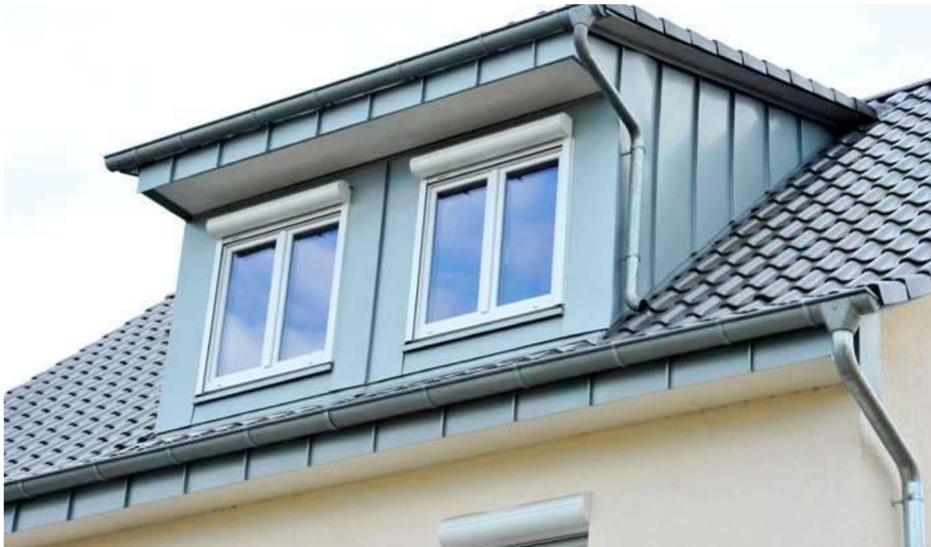
Die Dachentwässerung wird mit einer halbrunden, vorgehängten Dachrinne inkl. der benötigten Fallrohre und Formstücke ausgeführt. Ebenso wie sämtliche Anschluss- und Kehlbleche sowie alle weiteren Verblechungen werden alle Arbeiten in wartungsfreiem Titanzink ausgeführt.
