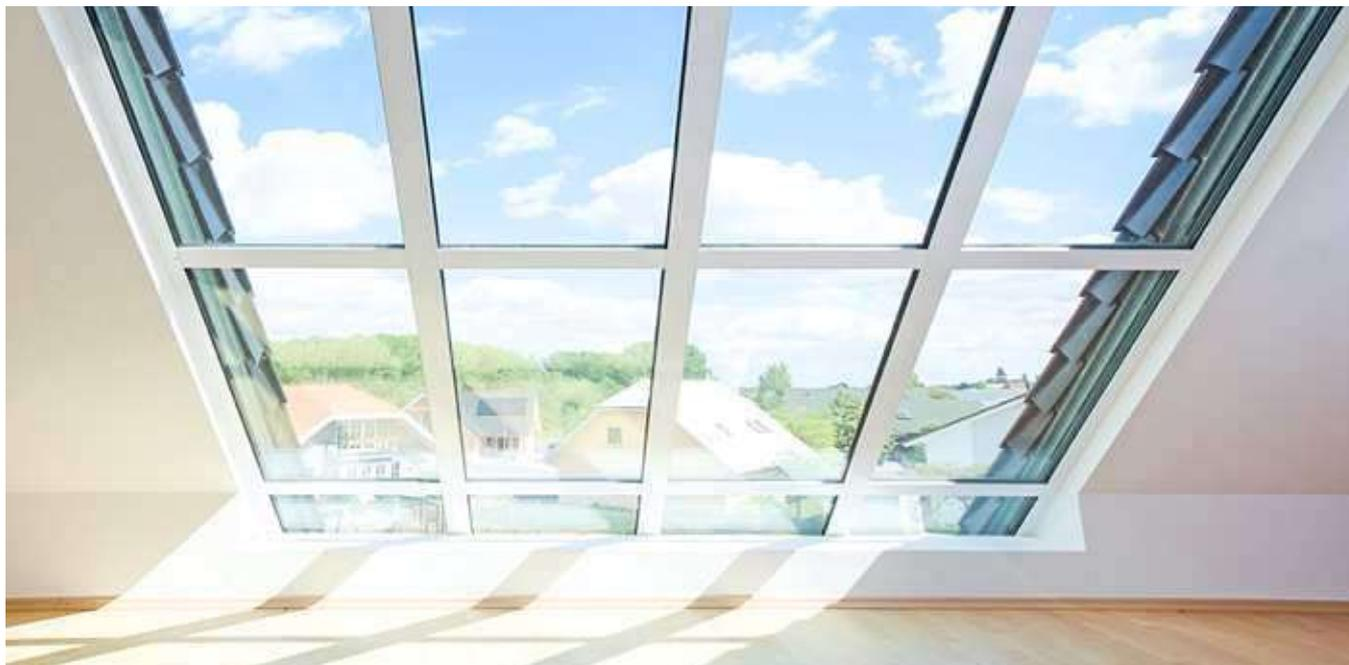
Die Dachflächenfenster werden in der geplanten Größe als Klapp-Schwingfenster aus weißem Kunststoff mit Wärmedämmung ausgeführt und erhalten einen Eindeckrahmen aus Aluminium mit Anthrazit-Metallic-Lackierung.
