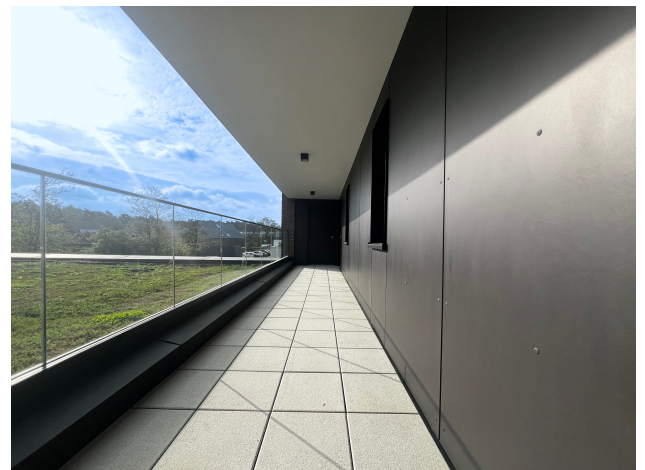
Außenzugang zur Wohnung
