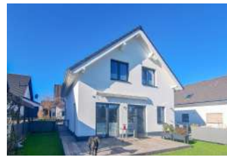
K6771 - Bad Münsteriefel-Nöthen , Neubau, Niedrigenergiehaus, Bj. 2020, Wfl. 104, Grdst. 334 m 2
