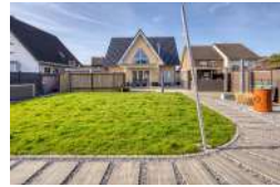
K6915-Bergheim-Oberaußem, EFH, Bj. 2009, 148/735, Wärmepumpe, € 650.000 Seite 10
