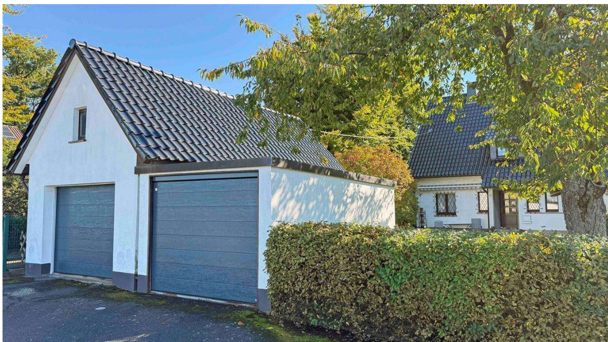
2 massive Garagen. Die Dächer wurden 1999 erneuert
