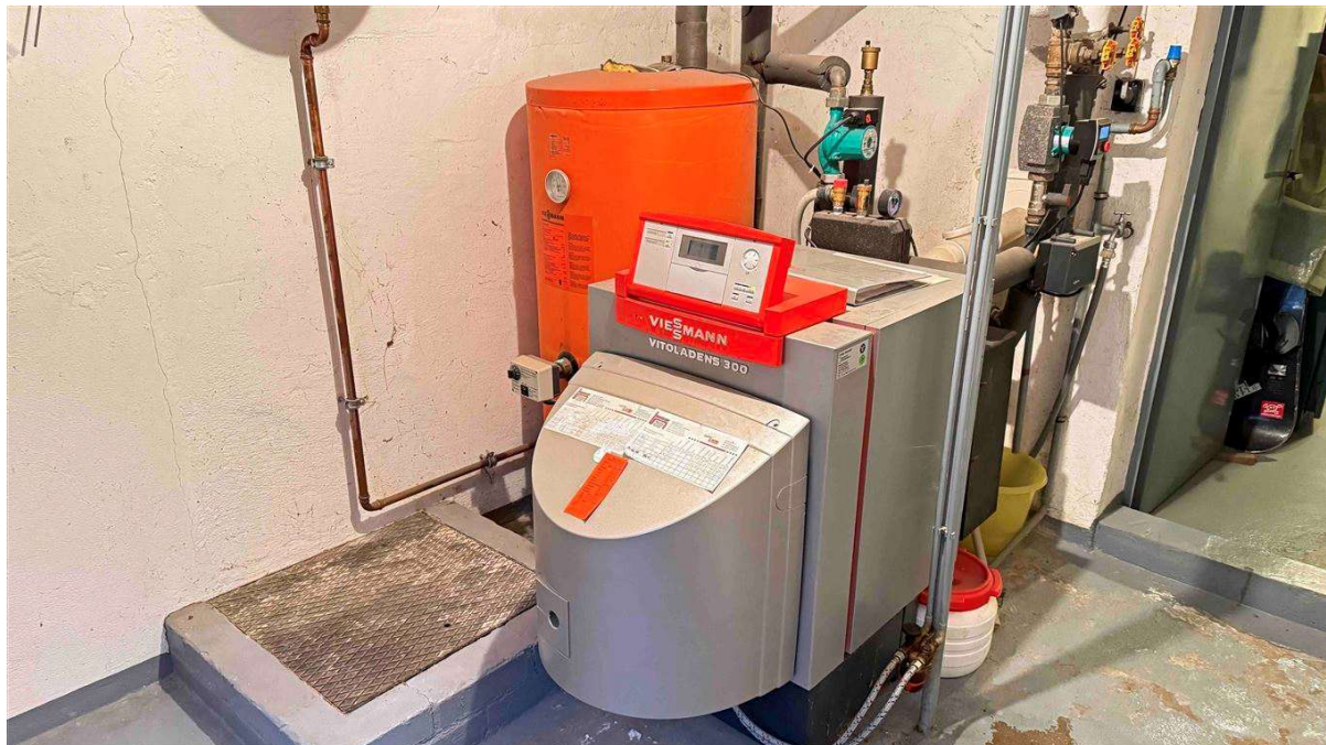
moderne Öl-Zentralheizung Baujahr 2010 (Brennwert)
