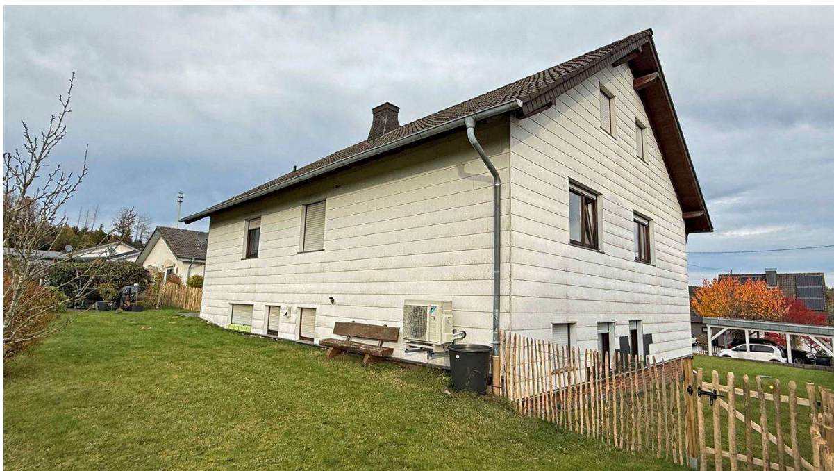
Hausrückseite, Fassade an den Wetterseiten gedämmt
