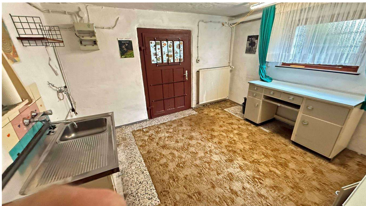
ebenerdig begehbare Keller; hier: Waschküche
