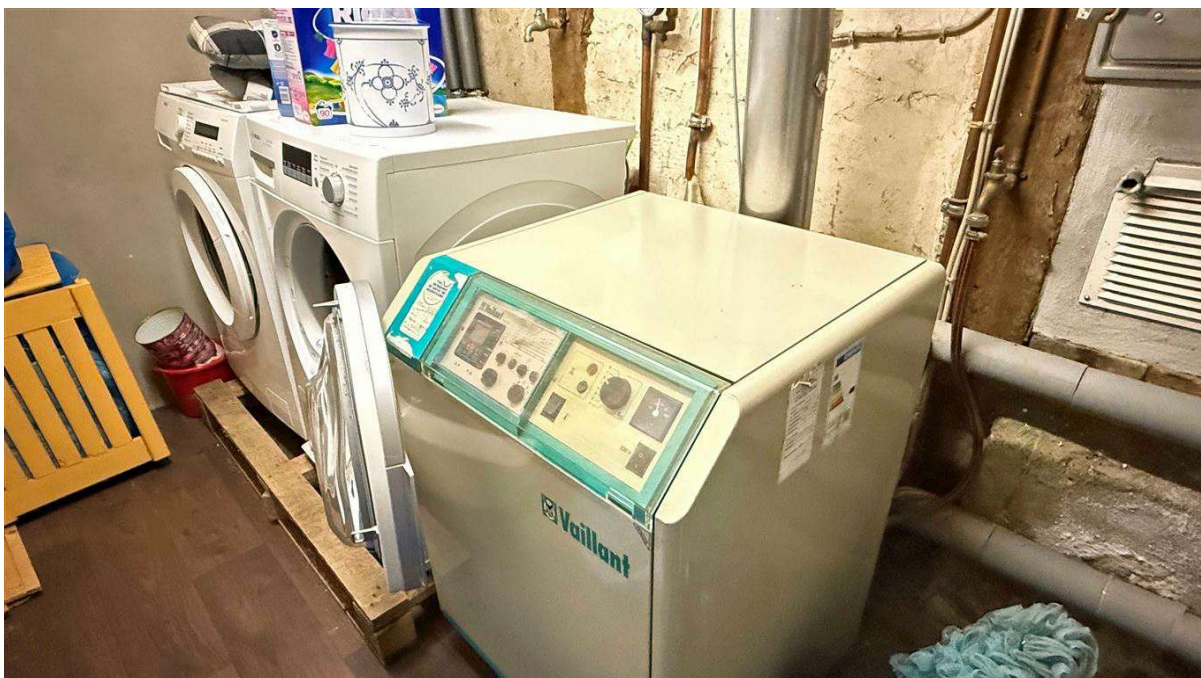
Flüssiggas-Zentralheizung, Baujahr 1996
