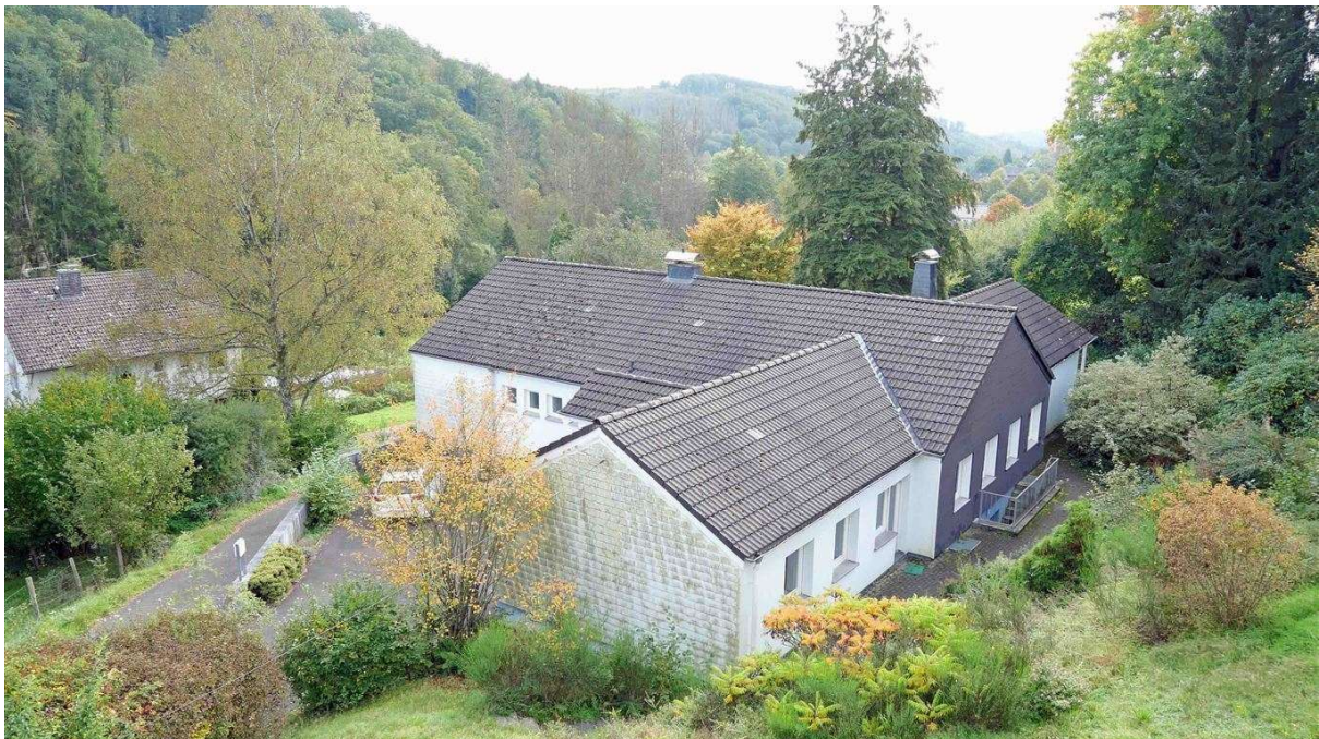
das Dach wurde 1993 erneuert und gedämmt
