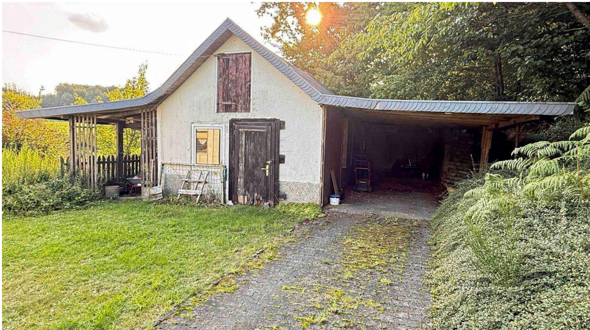
Nebengebäude (ehem. Stall) mit Carport/Unterstand
