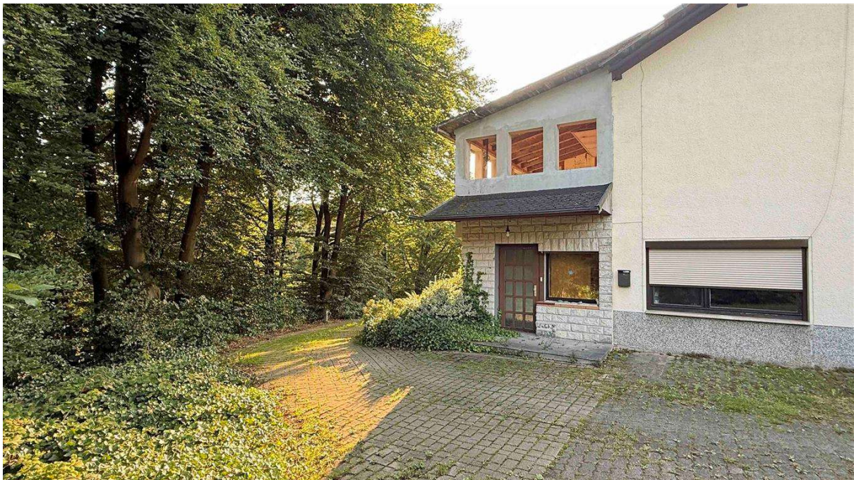
Eingang Einliegerwohnung (55 m 2 )
