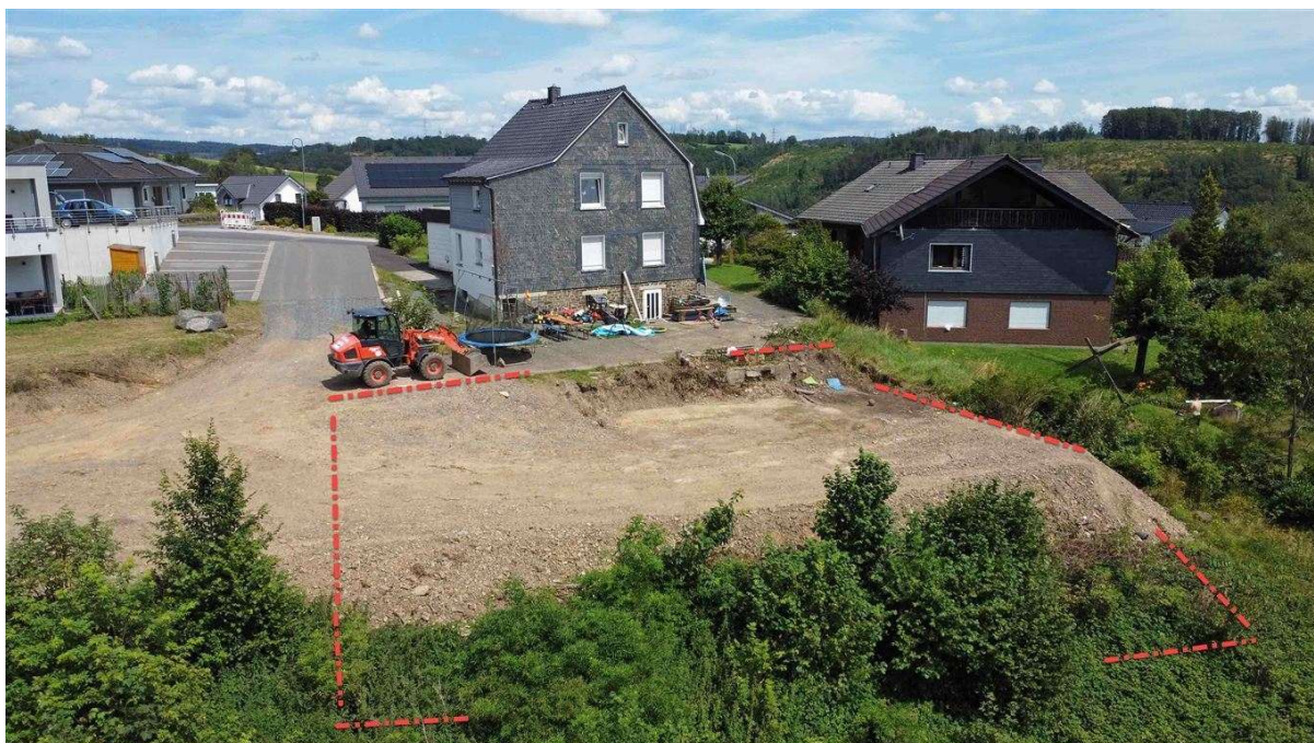
Ansicht vorhandenes Grundstück (Süd-West)
