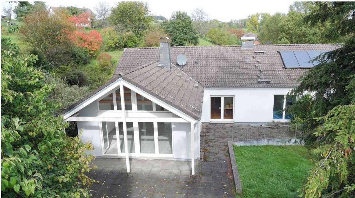
Rück-/Südseite mit Terrasse und Solaranlage
