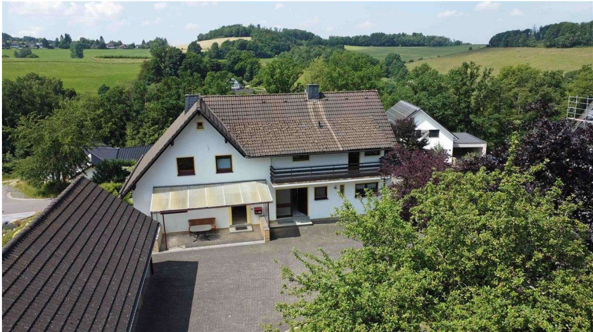
Rückseite: jedes Haus mit eigenem Eingang/Terrasse
