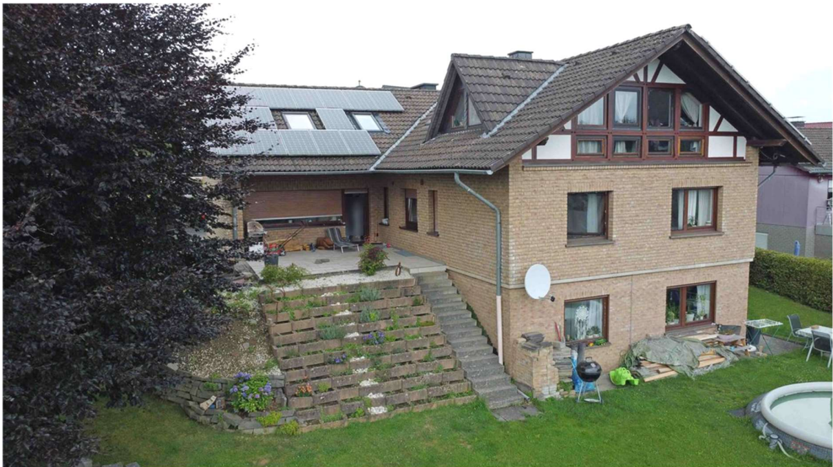
25 m 2 große, überdachte Terrasse ...
