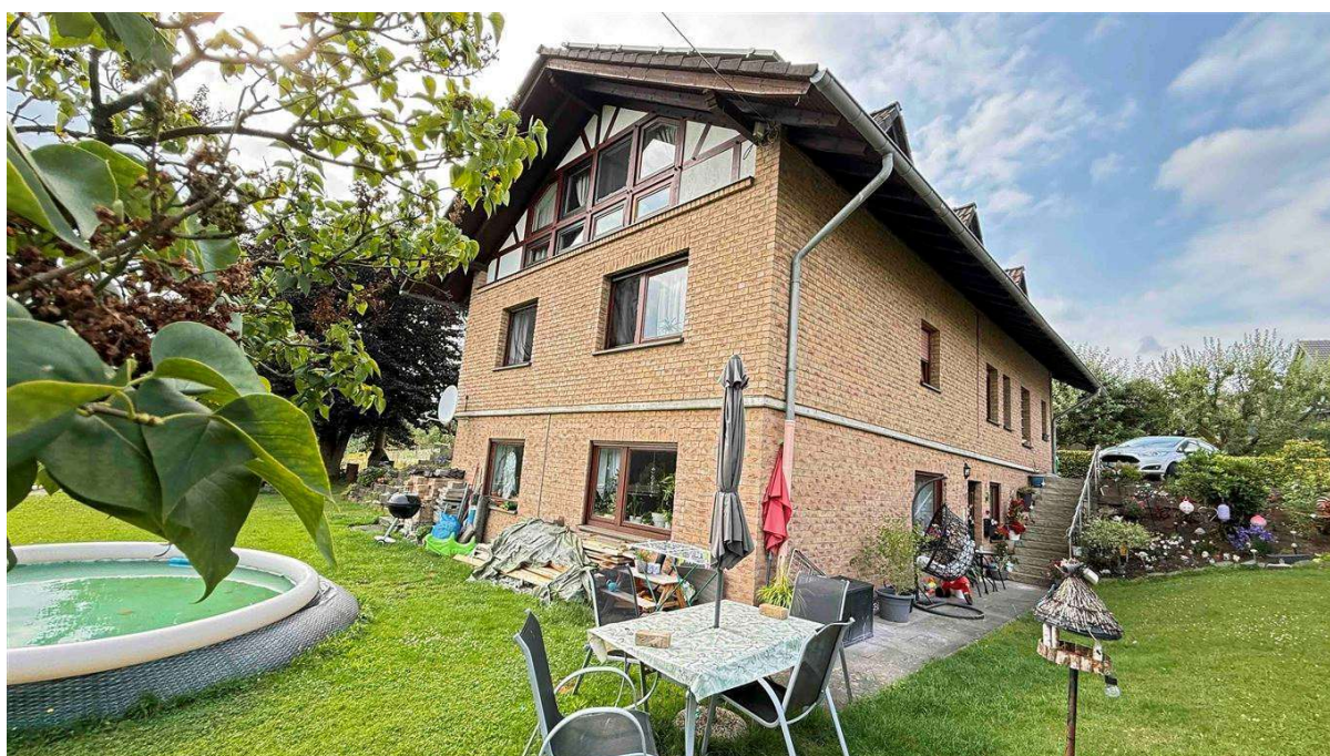
Treppe zum Nebeneingang/UG und Garten
