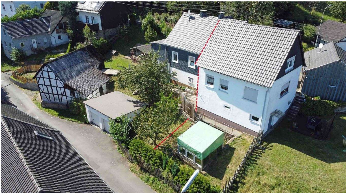
hinten an das Nachbarhaus teilweise angrenzend
