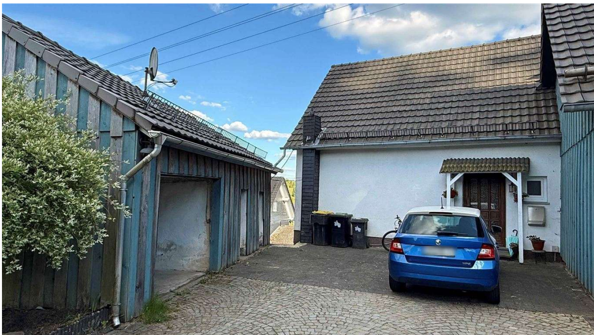
Gepflasterter Hofbereich. Rechts: Nachbarhaus...
