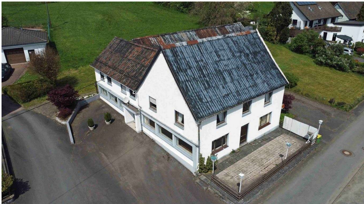
Südseite mit großer Terrasse
