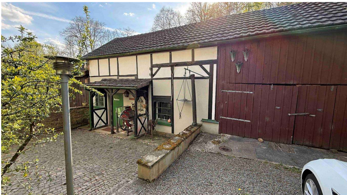
Nebengebäude mit Atelier und Garage/Scheune
