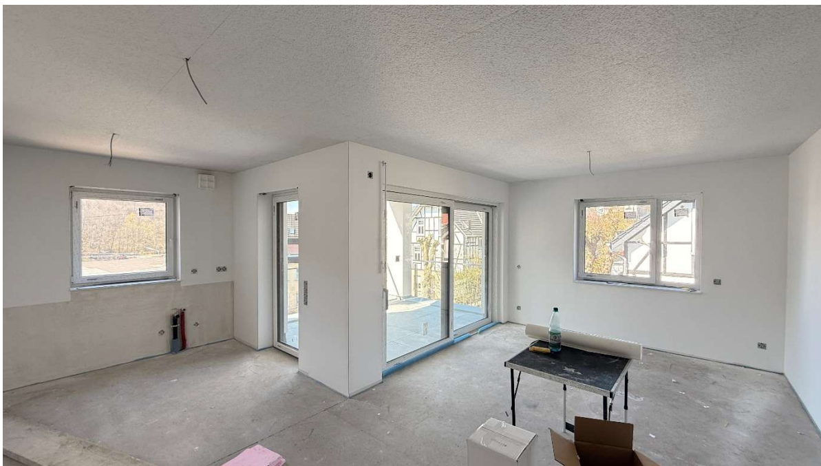
Innenarbeiten sind weit fortgeschritten
