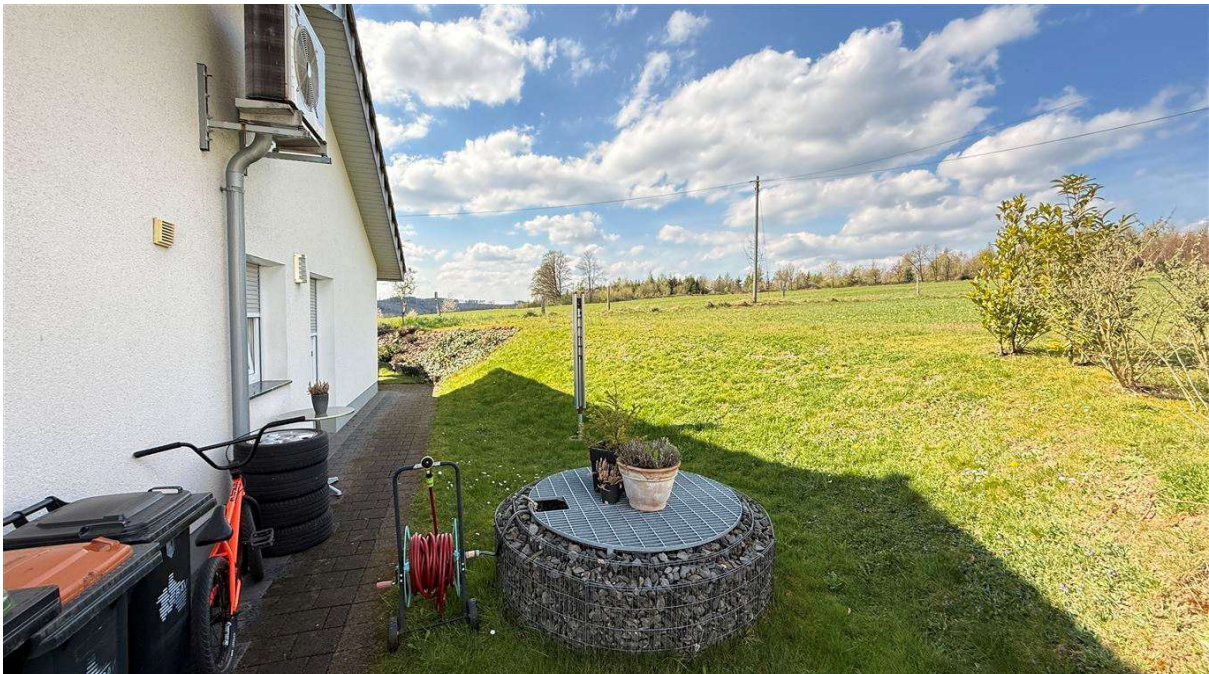
FB-Heizung mit Wärmepumpe, eigener Brunnen
