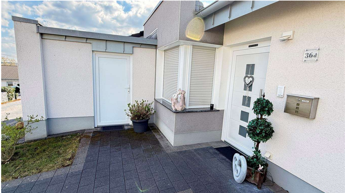
angebauter Abstellraum (Tür links), als Kellerersatz
