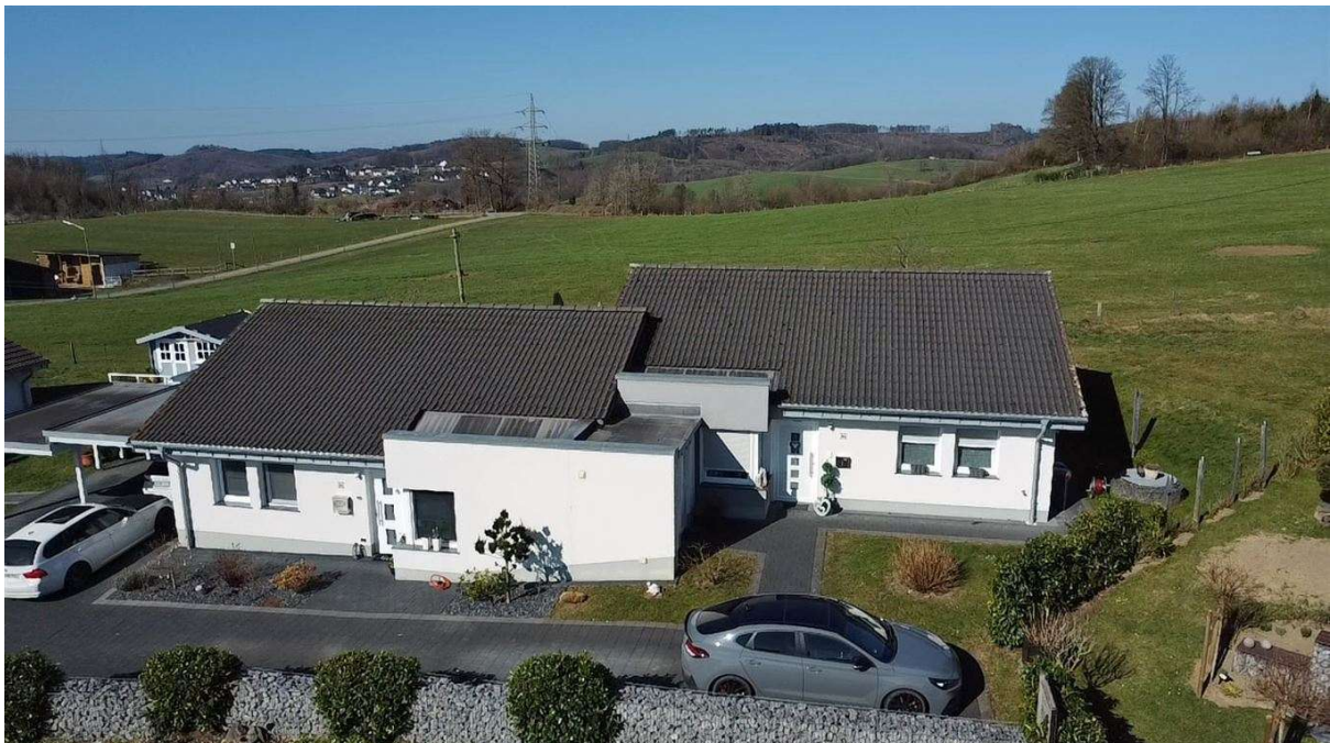
...zwei Pkw-Stellplätzen und Vorgarten
