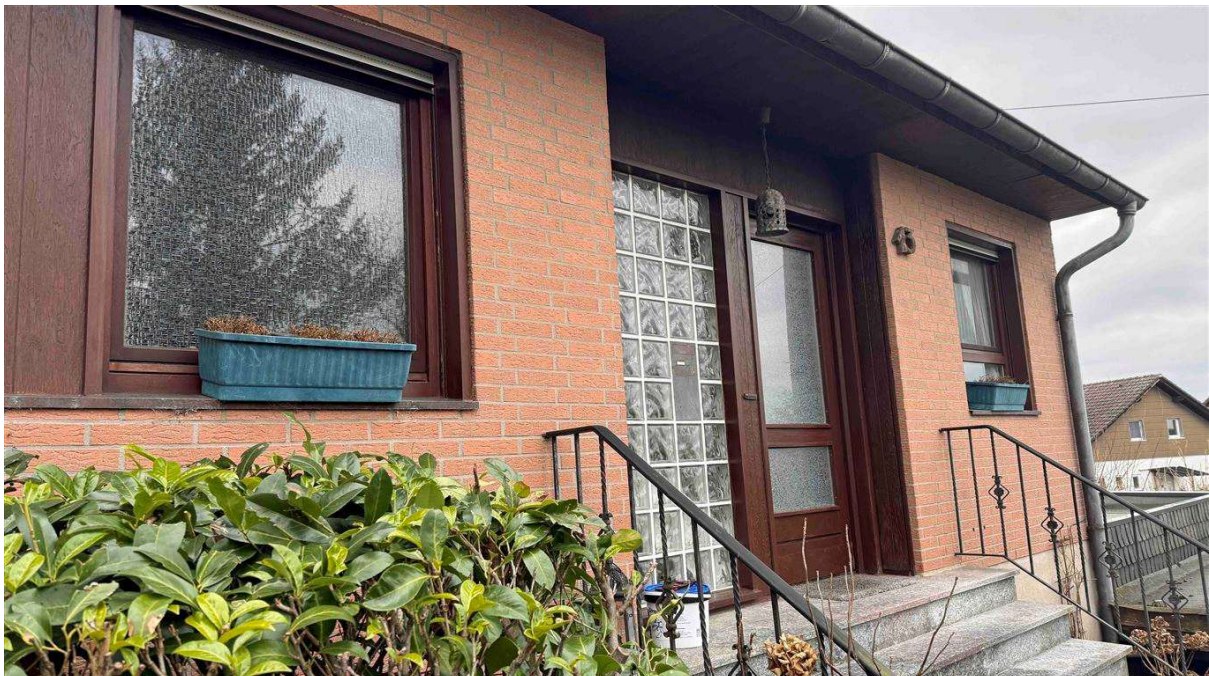
Eingangsbereich. Fassade mit Backstein-Klinker
