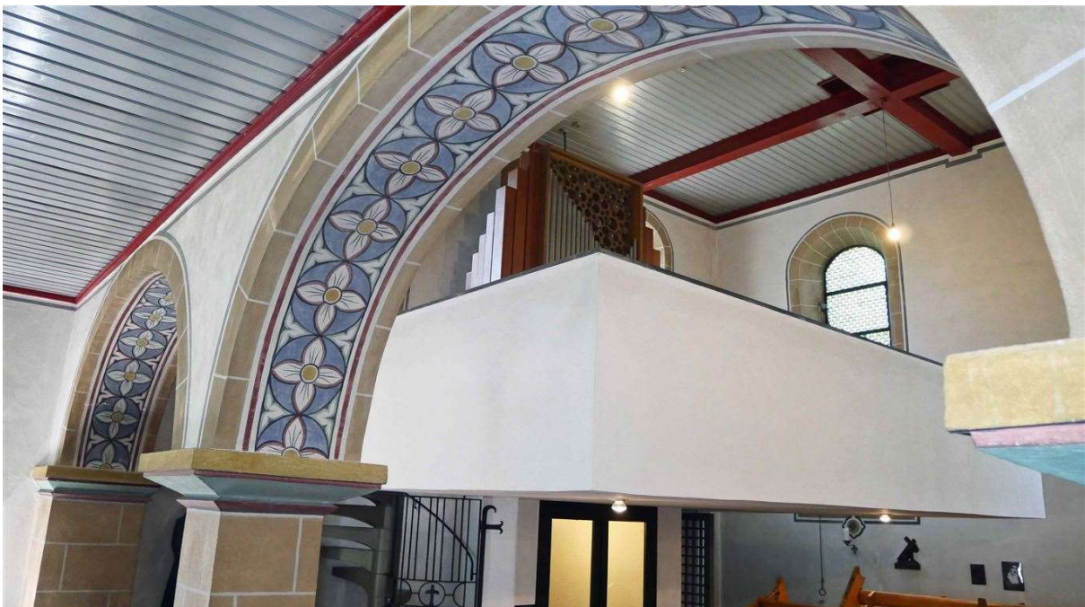
Chorraum. Der Kirchenraum ist ca. 6,8 m hoch
