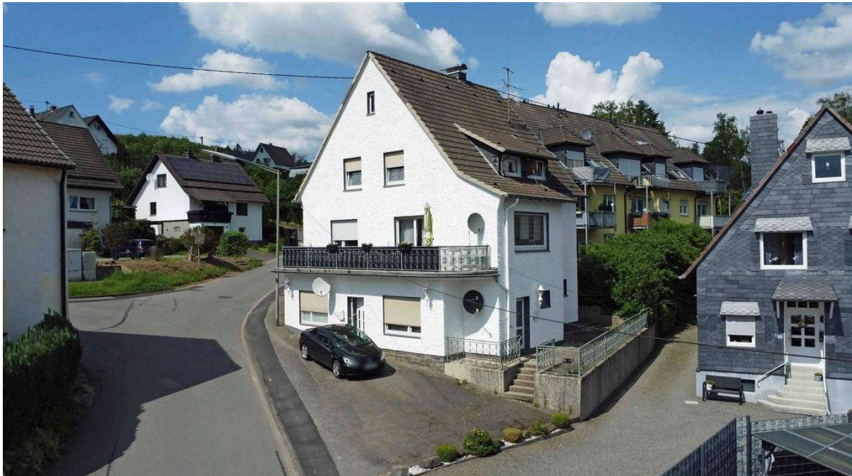
Rückseite mit separaten Eingängen z. Apartments im UG
