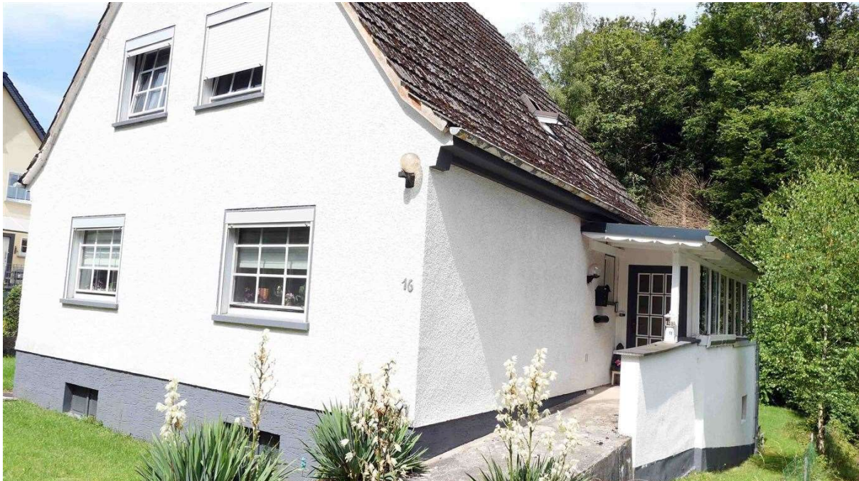
Eingangsseite mit Windfang
