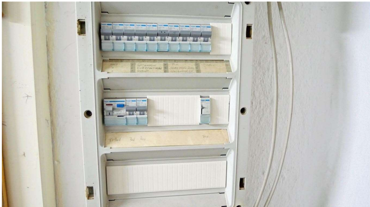
die Elektroinstallationen sind modernisiert
