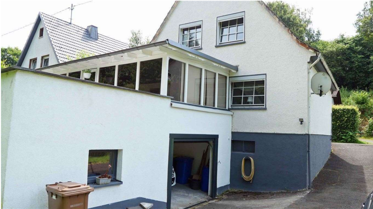
Garagenanbau mit Wintergarten und Terrasse
