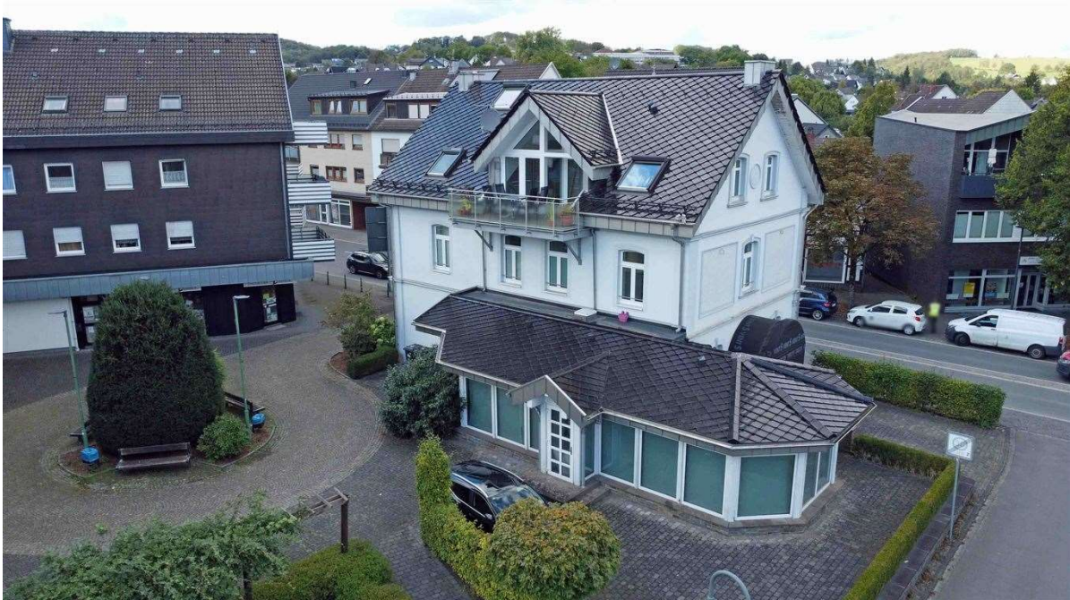
Hausrückseite mit Innenhof und...
