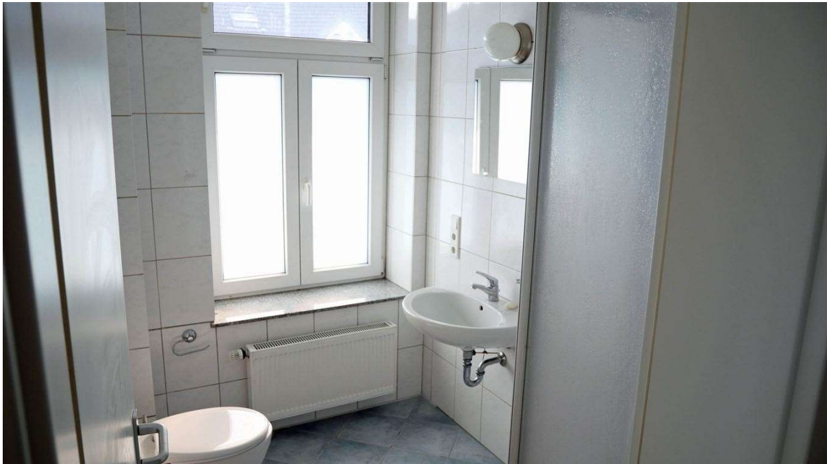
Alles 2004 komplett saniert / modernisiert
