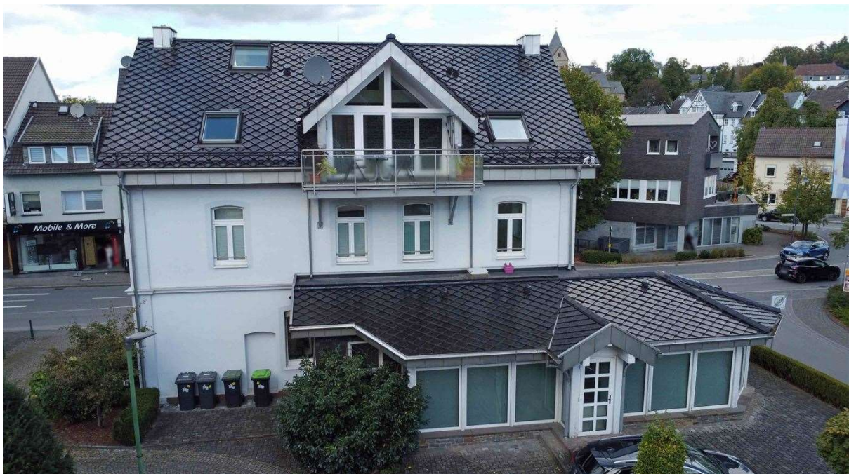
Rück-/ Südseite mit Anbau
