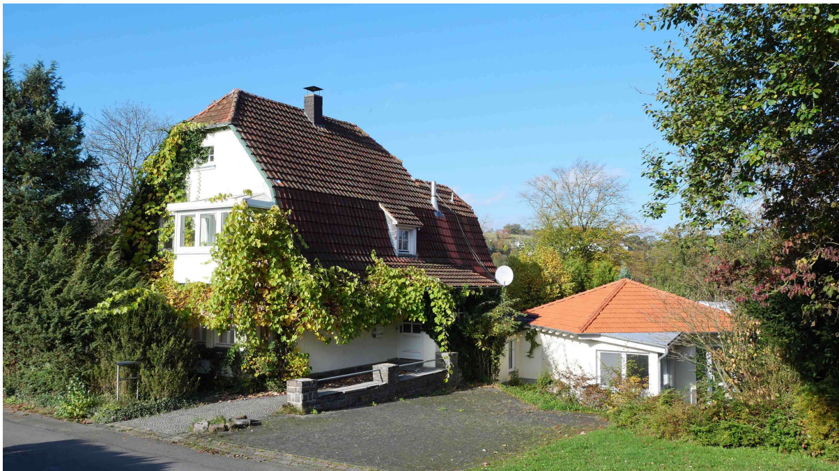
Eingangsfront mit Parkplatz
