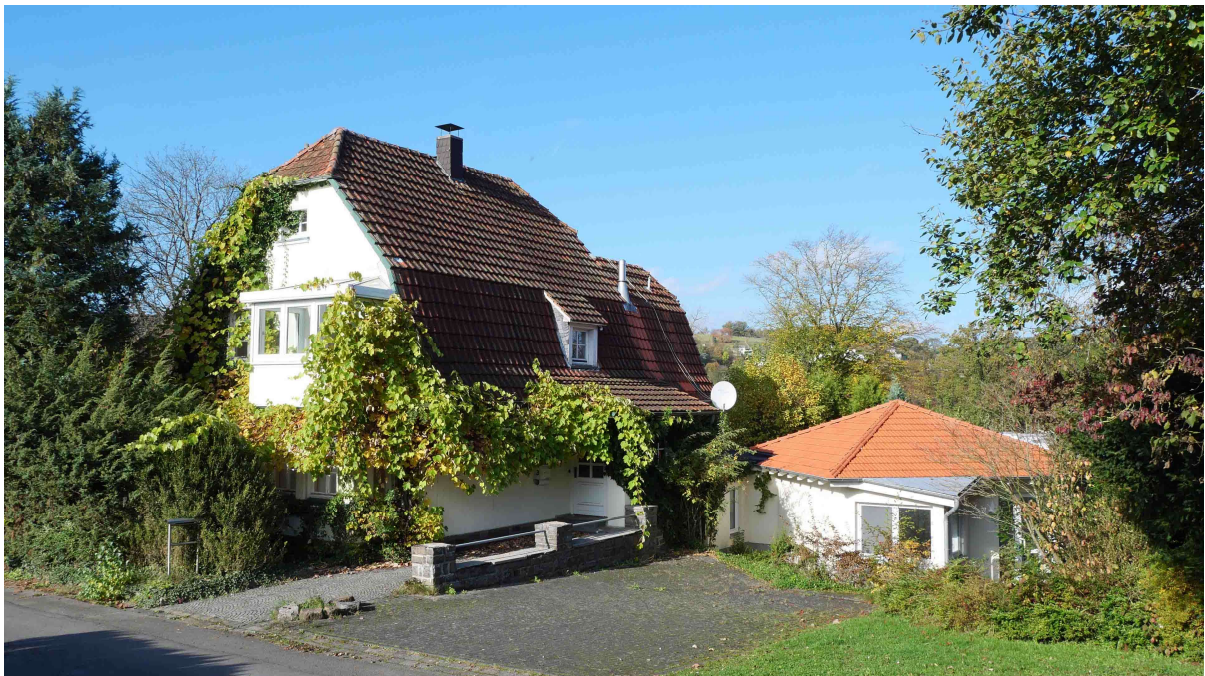
Eingangsfront mit Parkplatz
