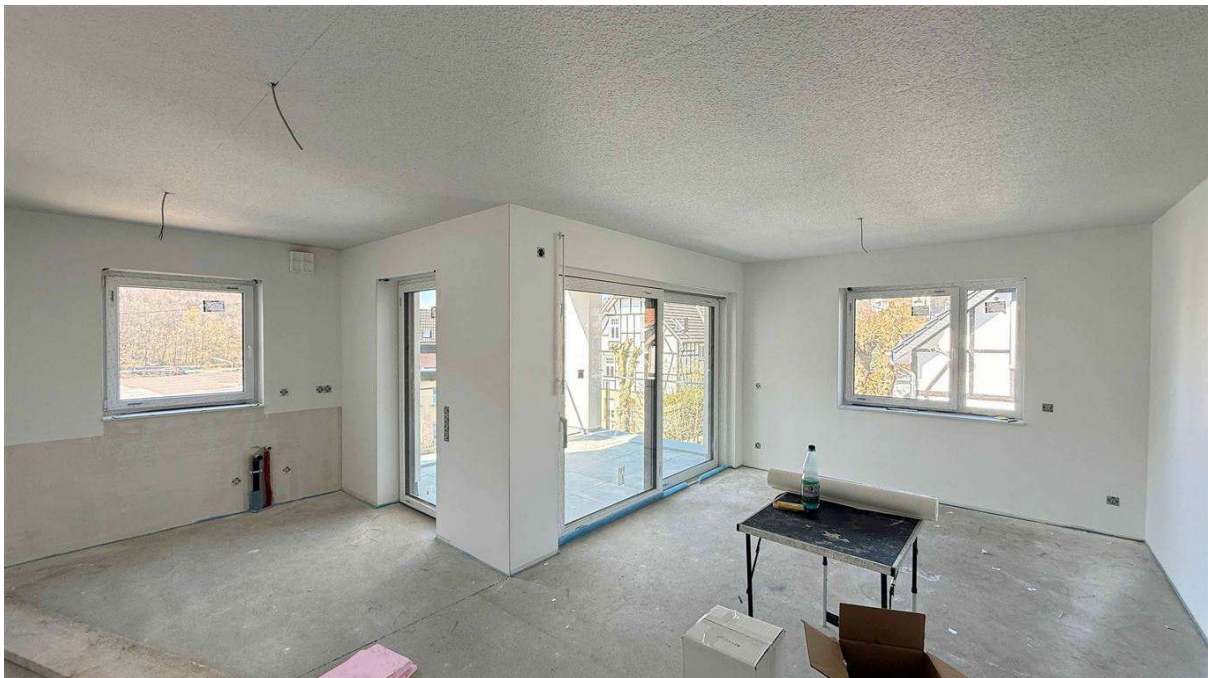
Innenarbeiten sind weit fortgeschritten
