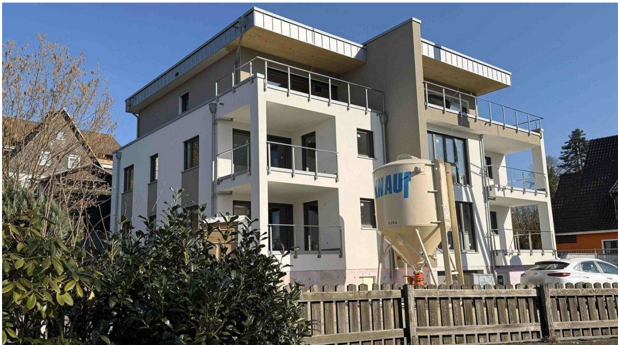
...das Gebäude, außen fast fertig, Stand Februar 2025
