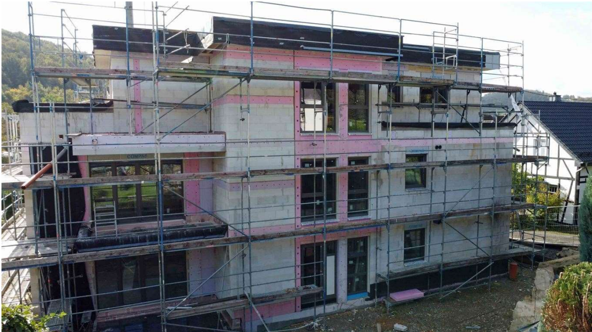
Ansicht Eingangs-/Rückseite November 2024
