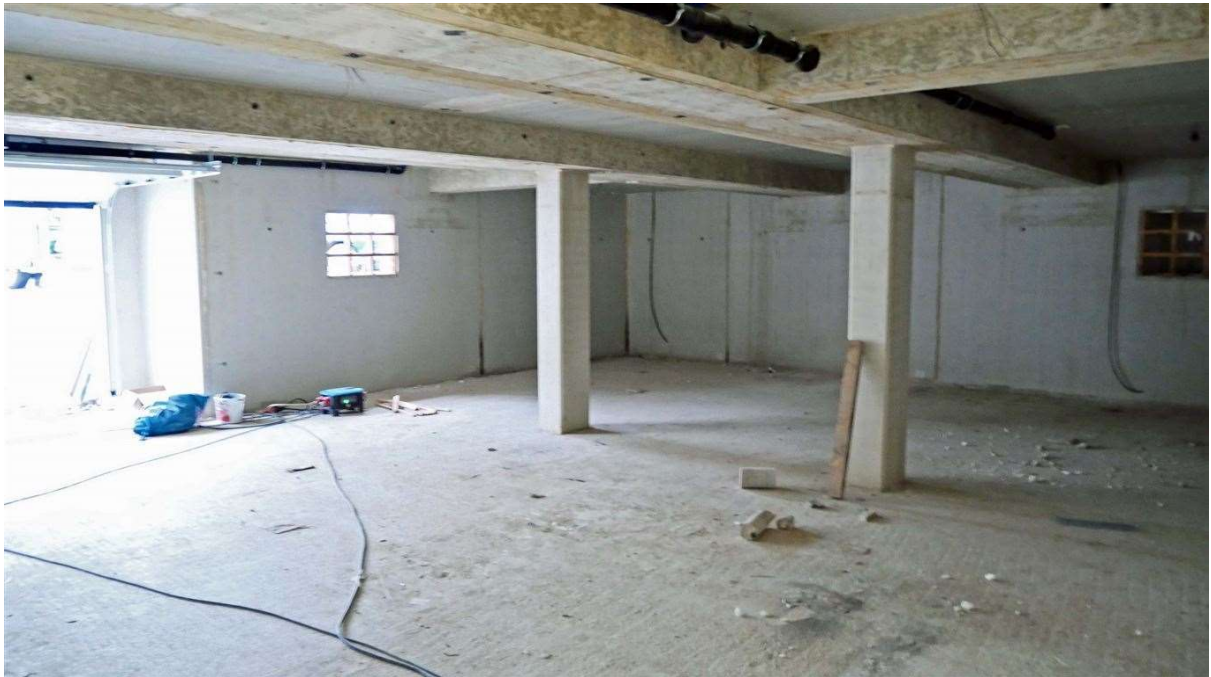
Tiefgarage mit Platz für 5 Pkw's
