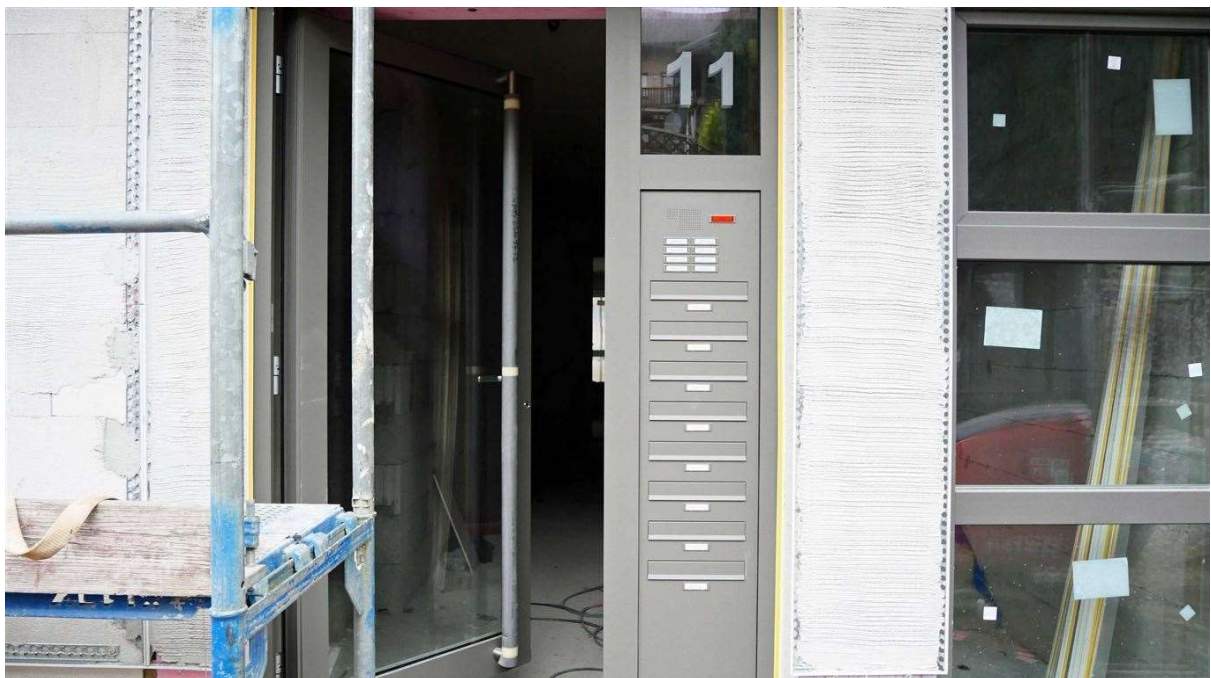
Fenster und die Eingangstür sind bereits eingebaut
