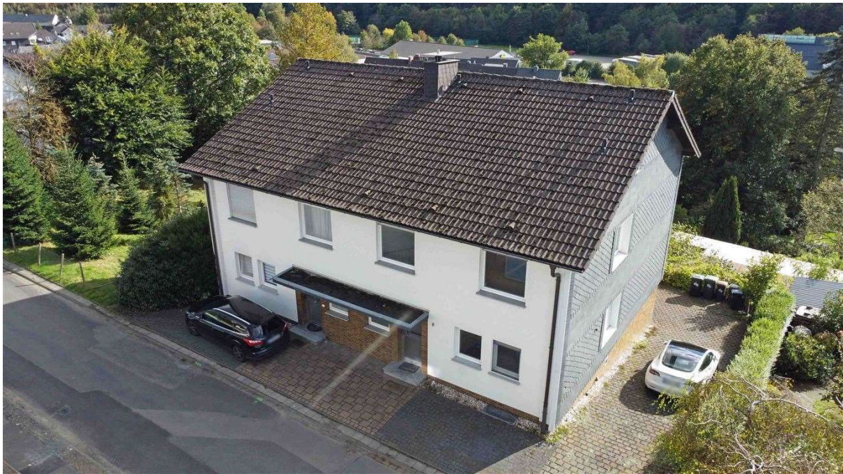
Eingangseite mit jeweils einem Stellplatz vor der Tür
