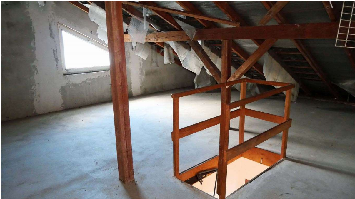
Ausbaureserve/Abstellraum unter dem Dach
