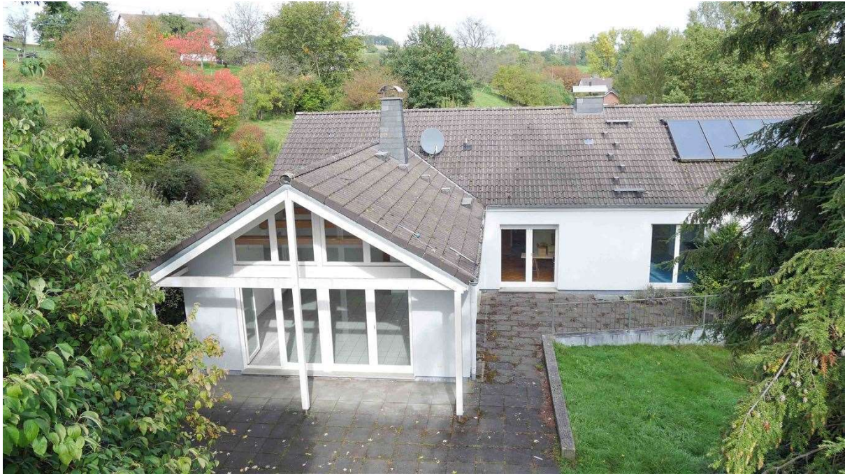
Rück-/Südseite mit Terrasse und Solaranlage
