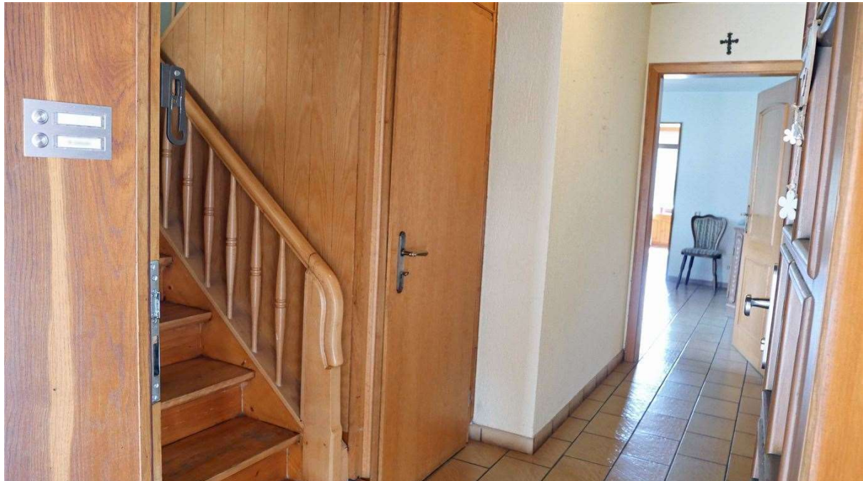
Blick in die Haustür mit Treppe zur ELW im DG
