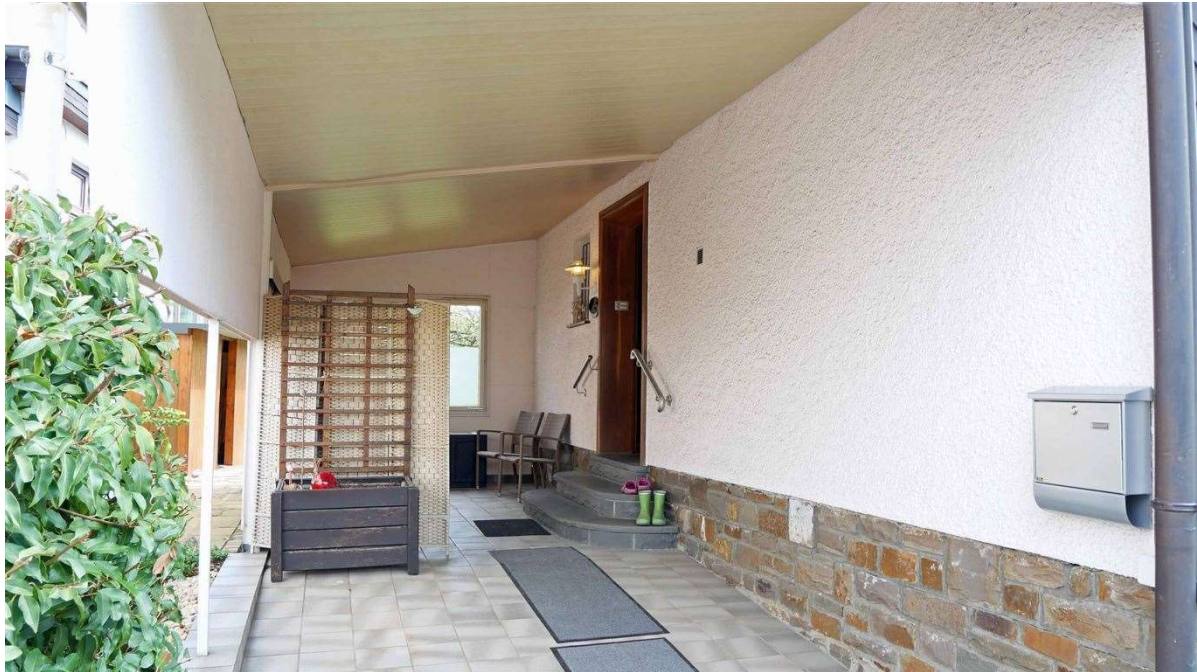
Eingangsbereich - kann als Carport genutzt werden
