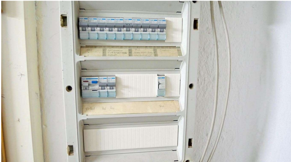
die Elektroinstallationen sind modernisiert
