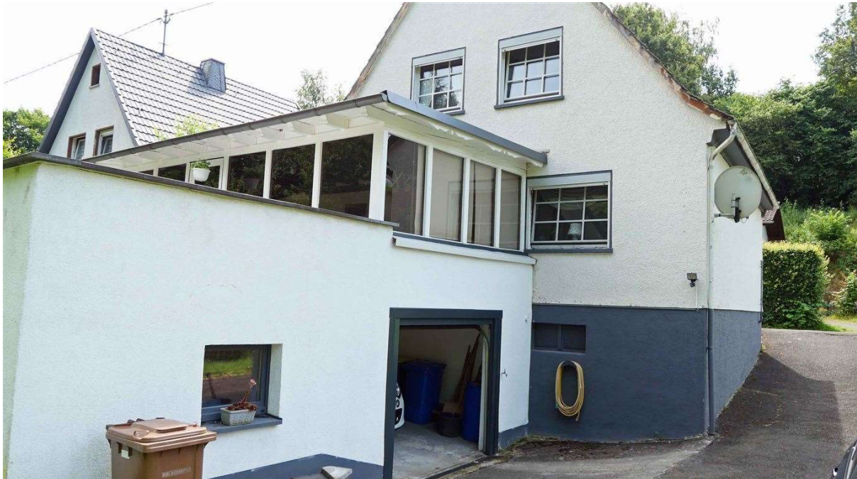
Garagenanbau mit Wintergarten und Terrasse
