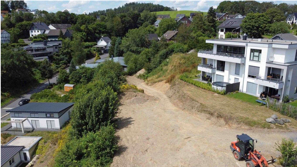
Ansicht von Süd-Osten
