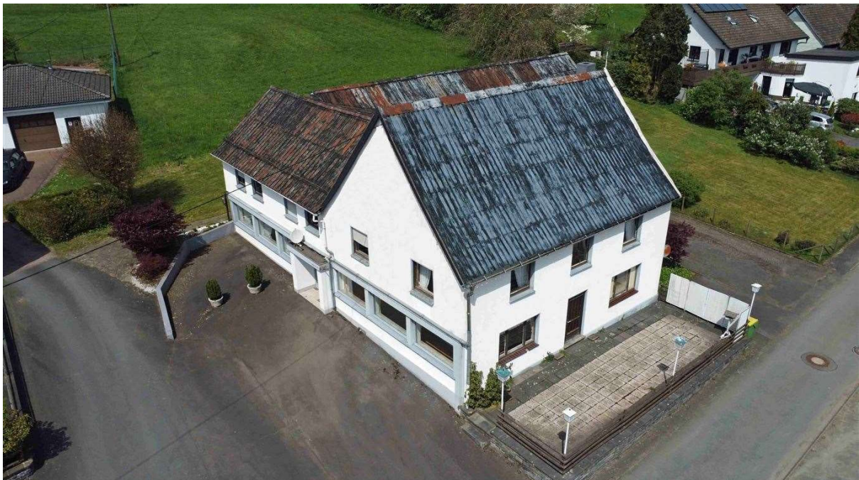
Südseite mit großer Terrasse
