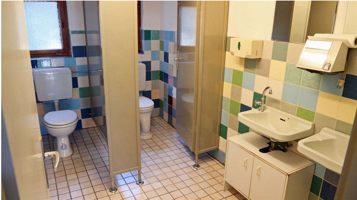
ältere, aber top gepflegte Toilettenanlage
