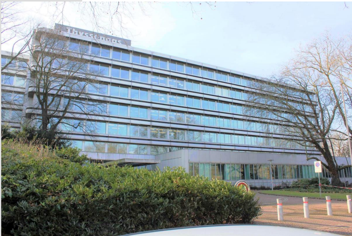
Aktuelle Ansicht Straßenseite
