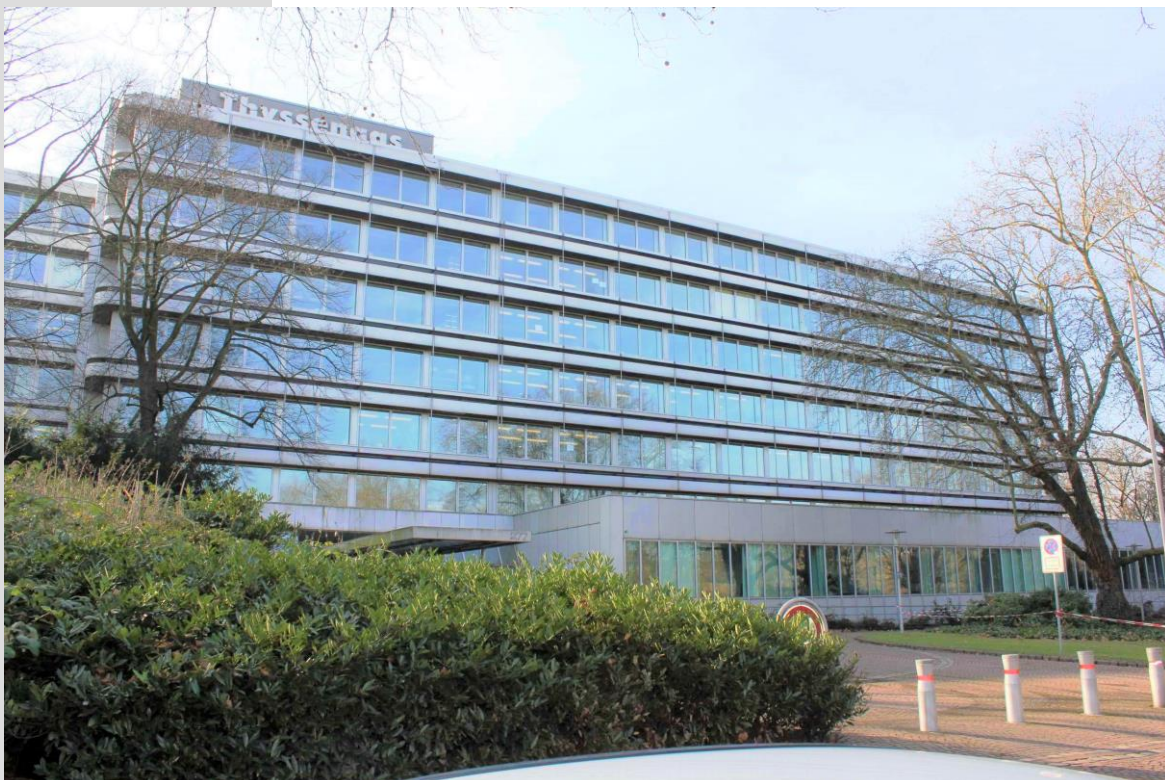
Aktuelle Ansicht Straßenseite
