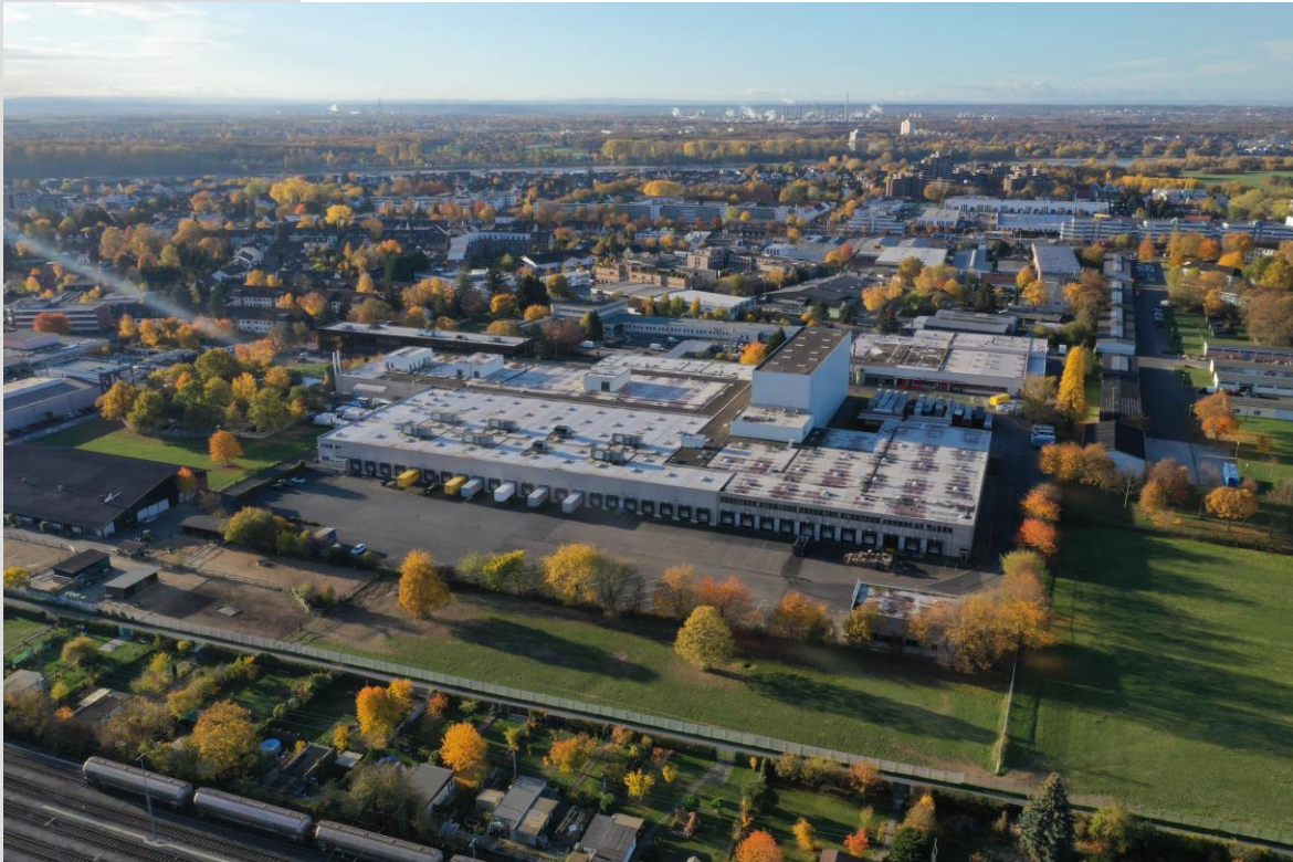
Luftbild Bestand - Neubaufäche
