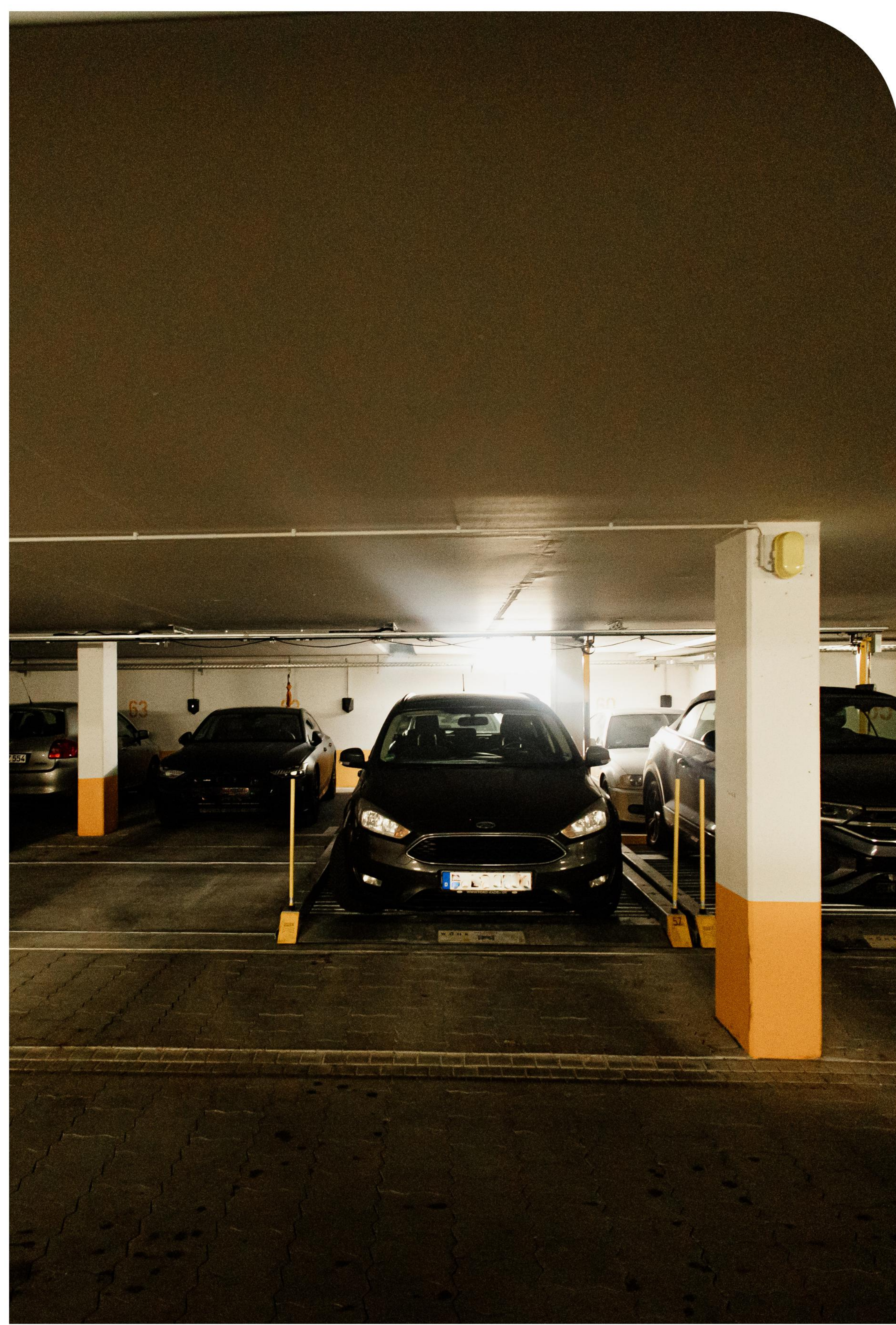
TERRASSE 2. OBERGESCHOSS & TIEFGARAGENSTELLPLATZ
