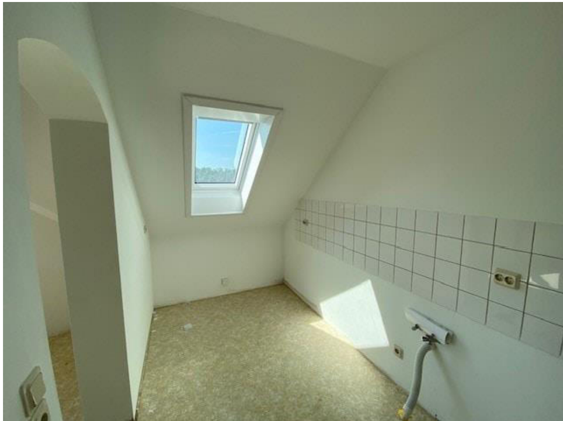
Küche mit Fenster und Dachschräge
