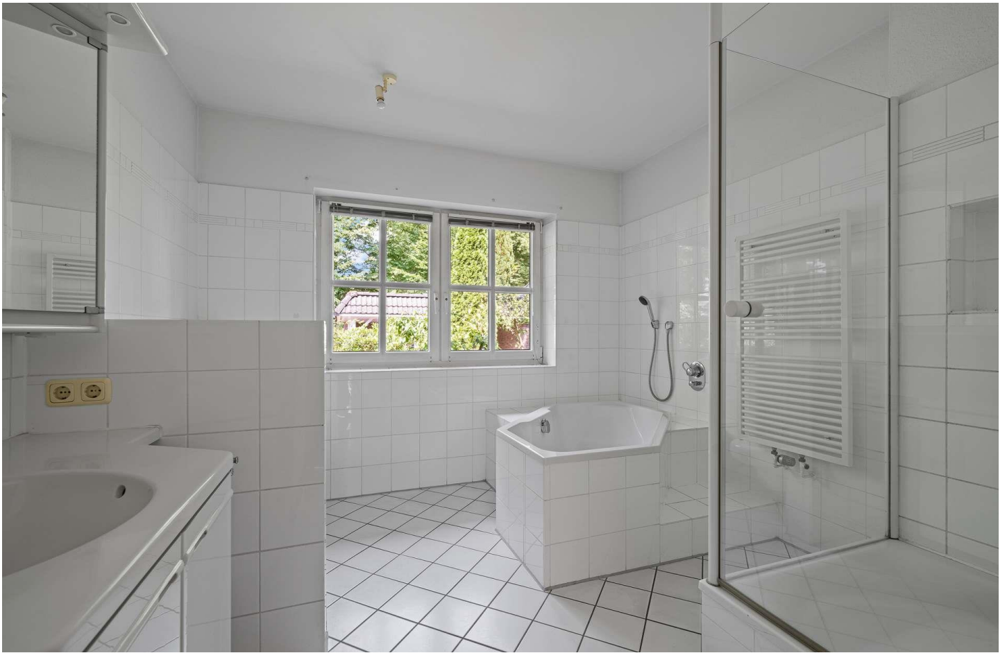
Badezimmer im Erdgeschoss
