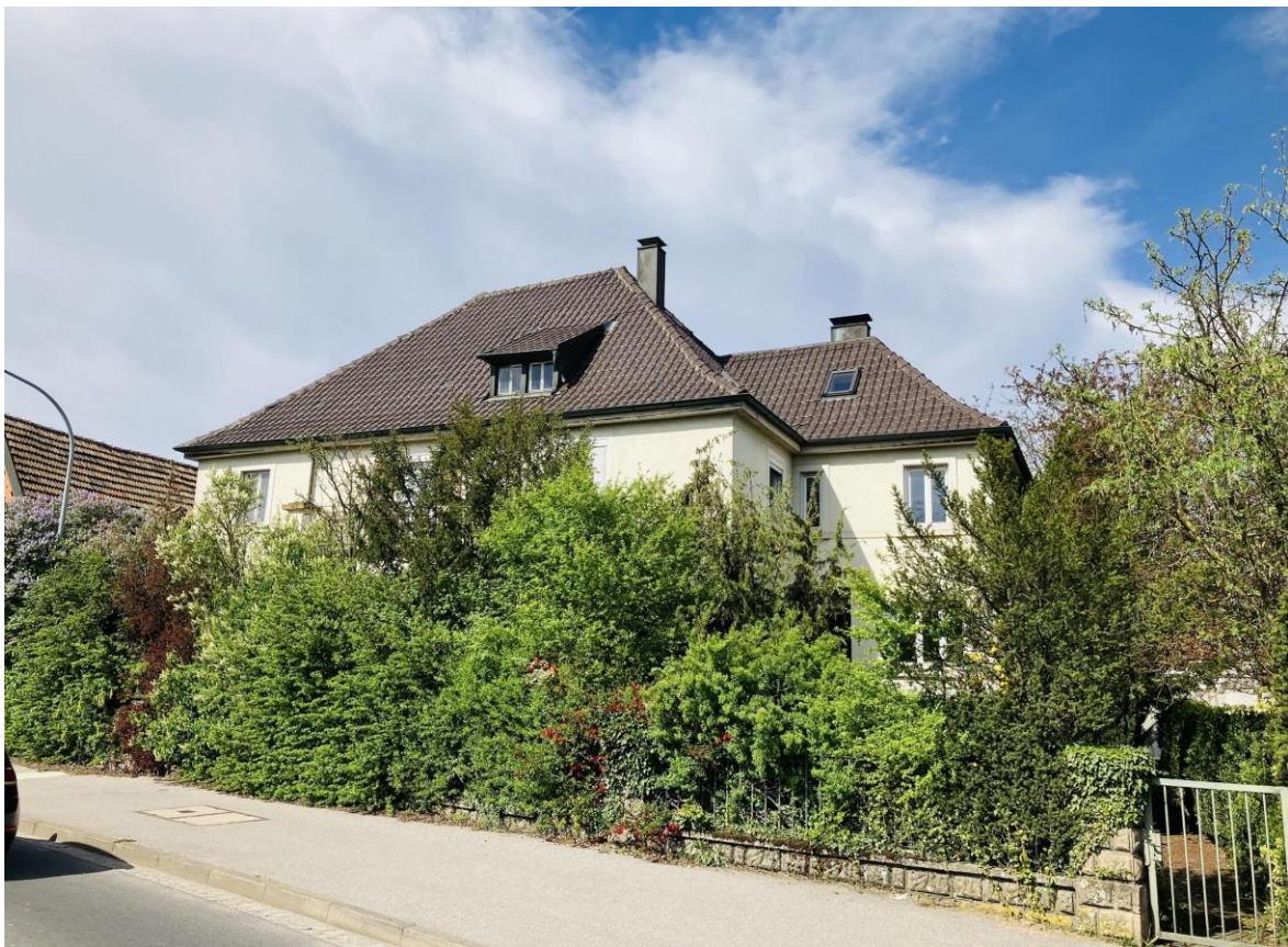
Abriss des Bestandsgebäudes an der Zeiler Straße
