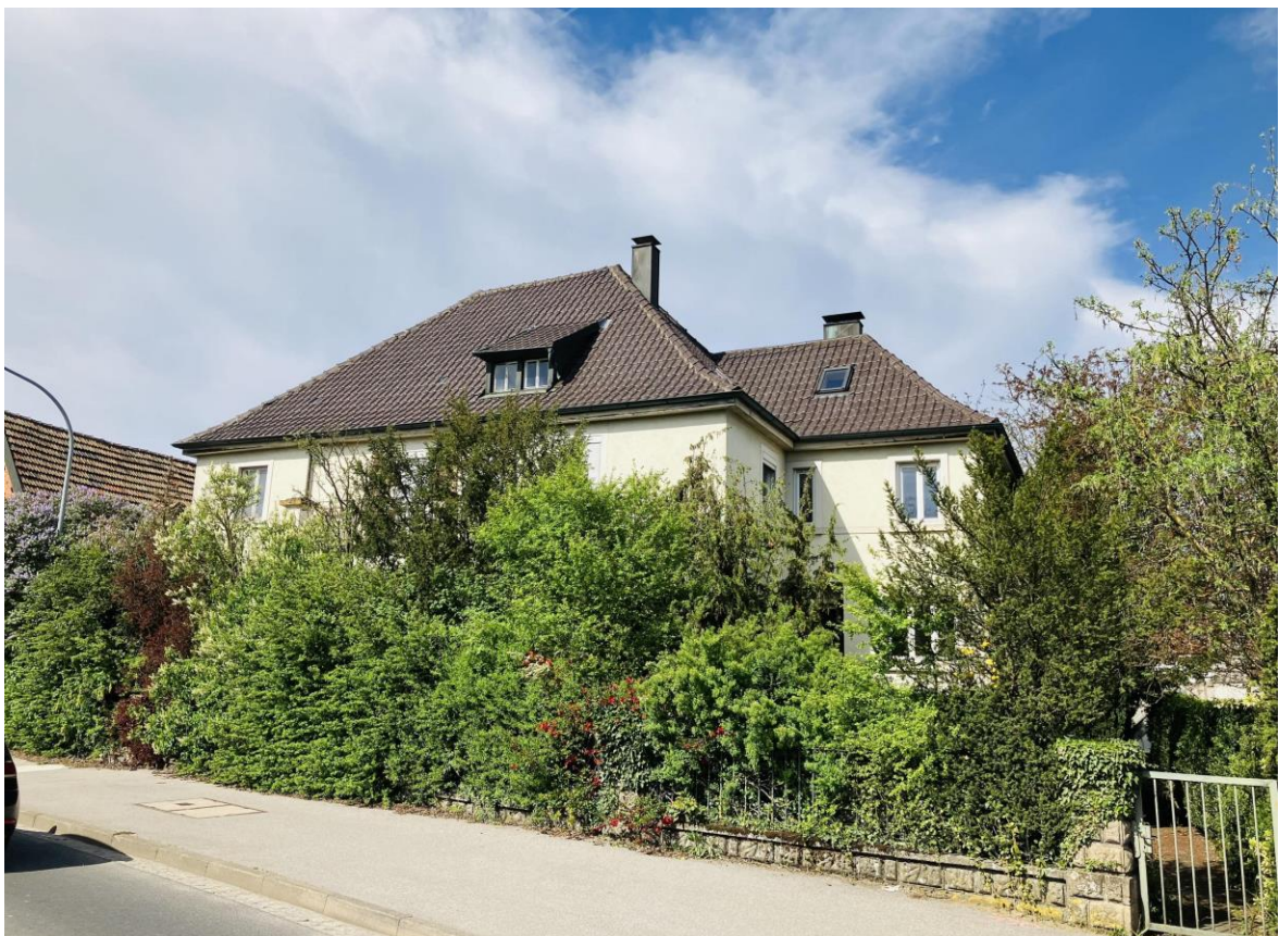
Abriss des Bestandsgebäudes an der Zeiler Straße
