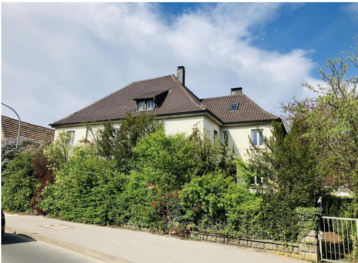
Abriss des Bestandsgebäudes an der Zeiler Straße
