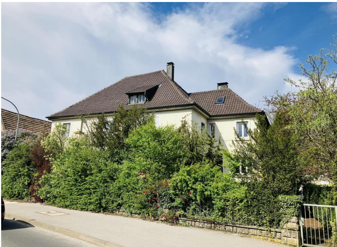
Abriss des Bestandsgebäudes an der Zeiler Straße
