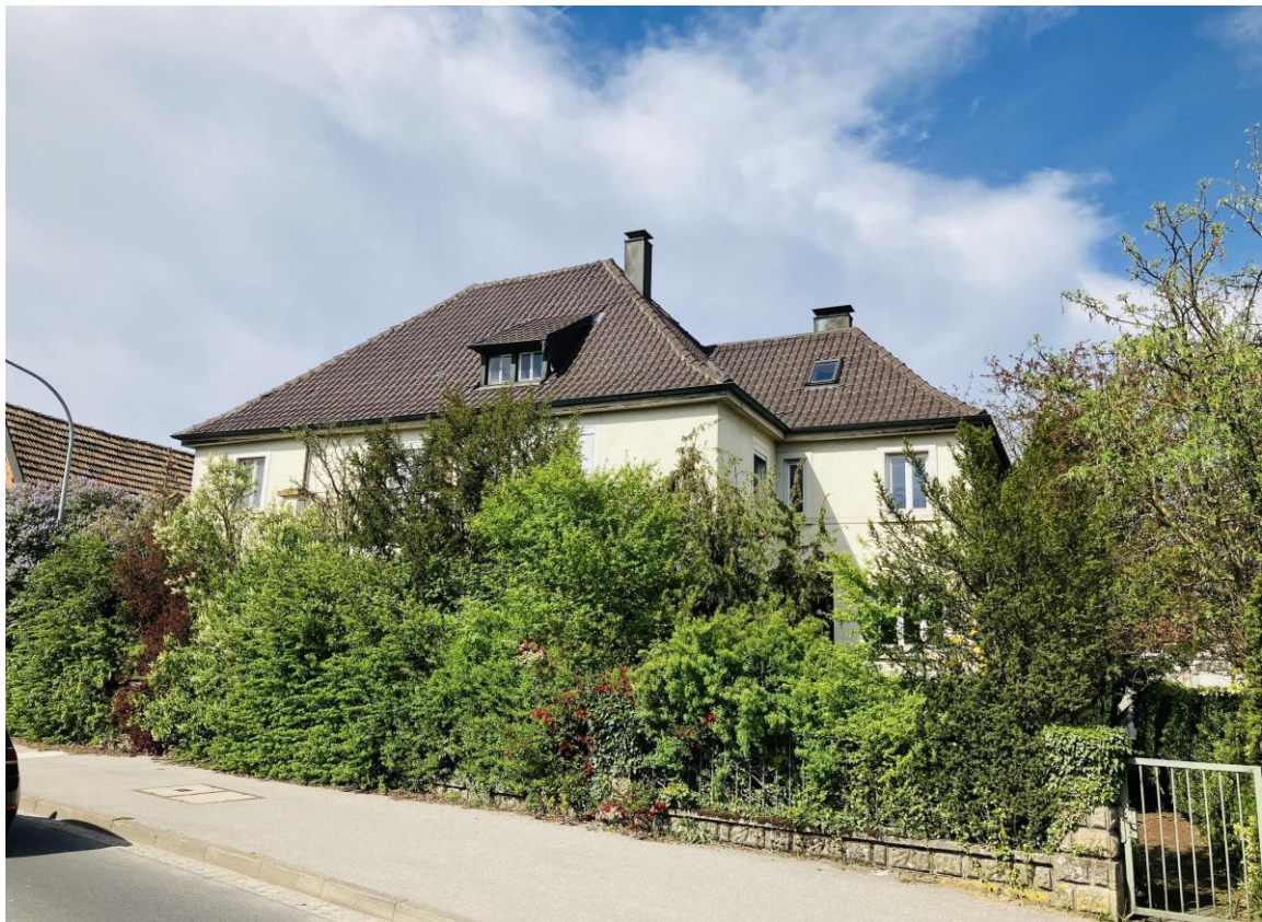
Abriss des Bestandsgebäudes an der Zeiler Straße
