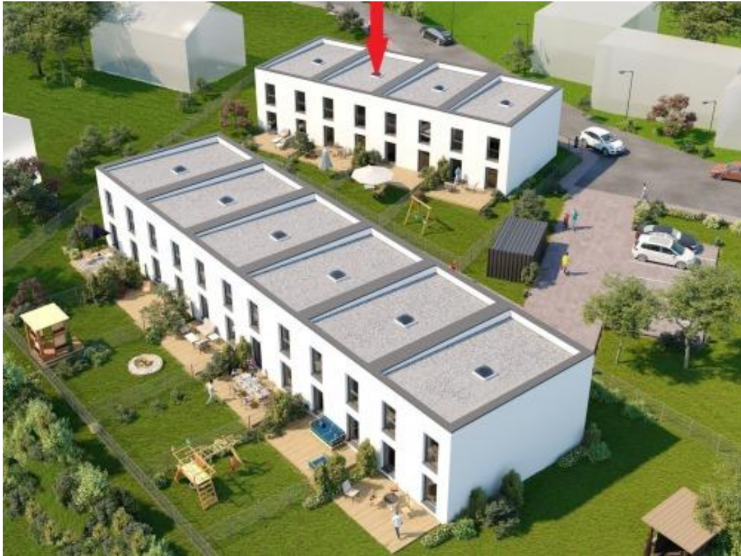
Ansicht der Anlage mit Pfeil - Haus B
