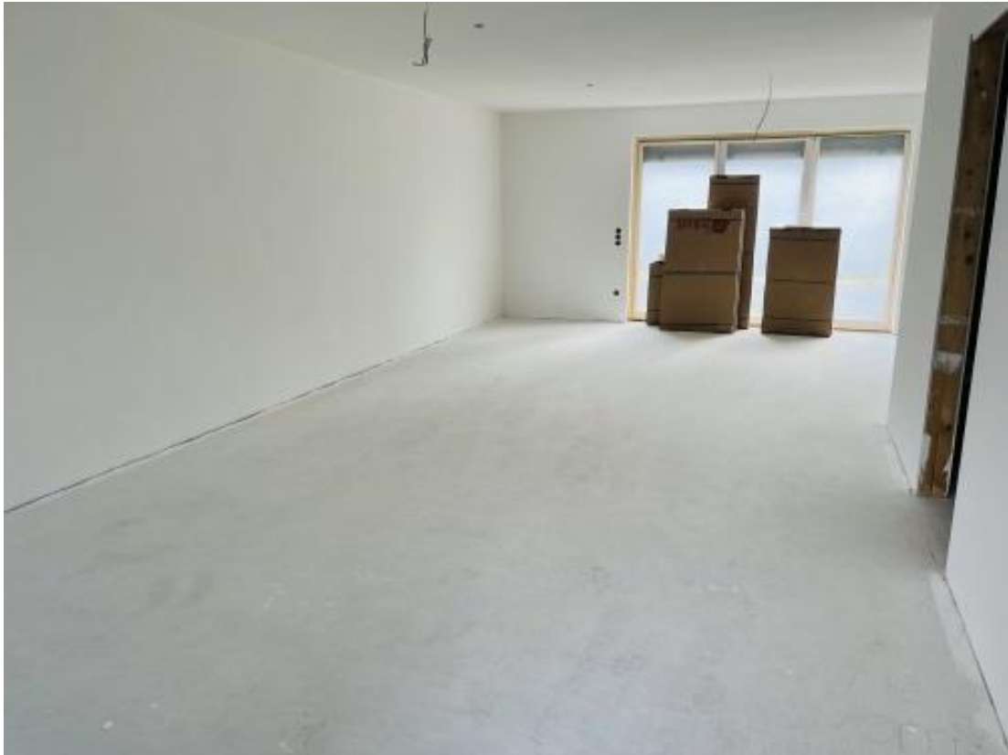
offenes, helles Wohnzentrum (EG -AusbauStand 09/2024)
