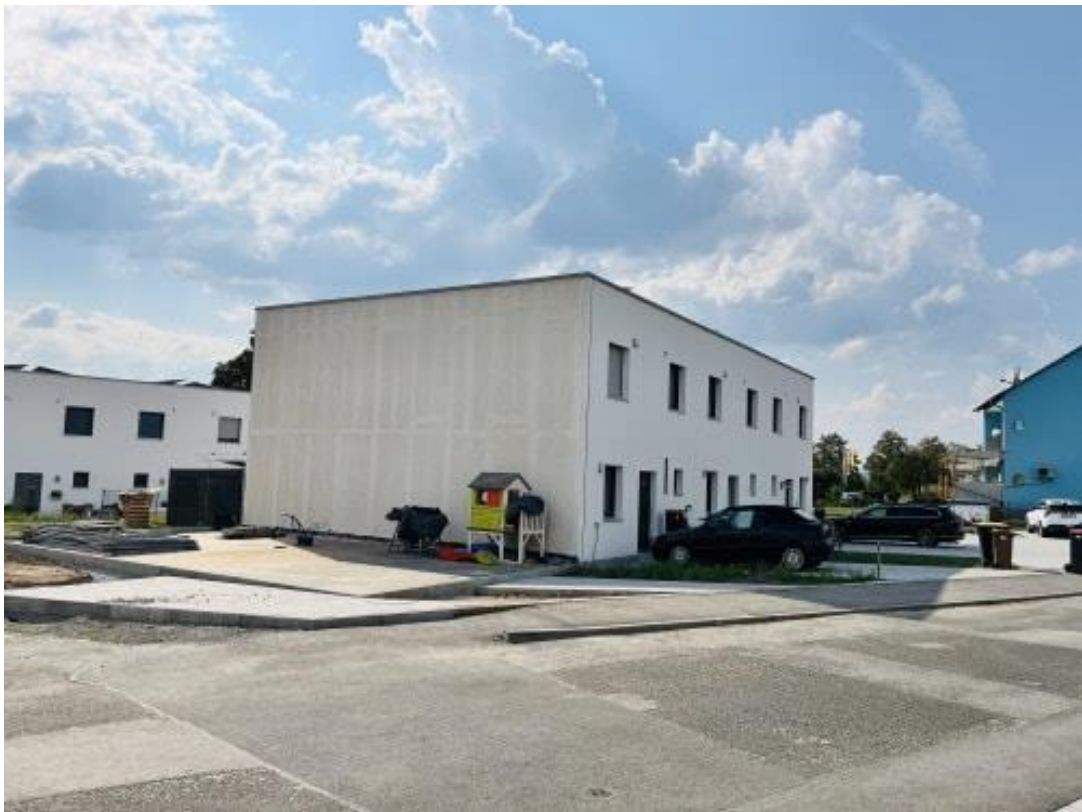
Nordostansicht der Anlage
