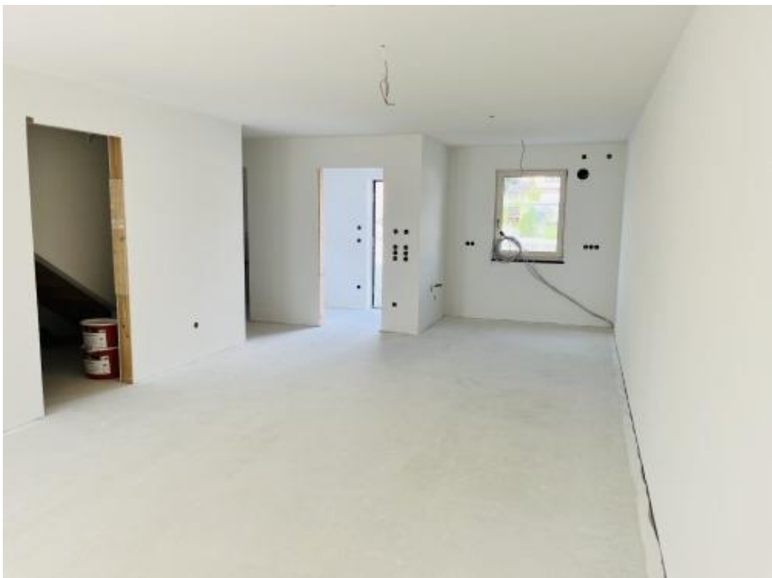
offenes, großzügiges Wohnen (EG; Küche und Eingang)
