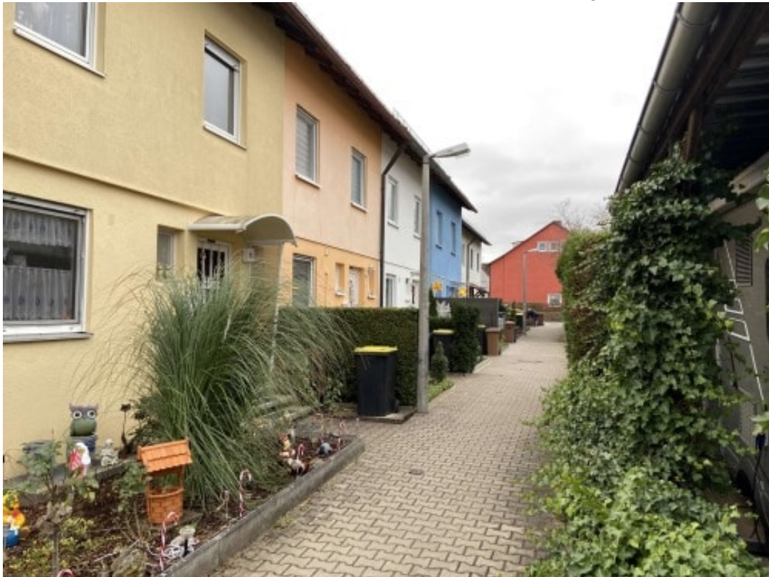
Hausansicht Eingang mit Weg
